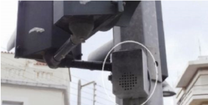
Σχήμα 9.22: Τυπική ηχητική διάταξη σε σηματοδότη για την εξυπηρέτηση των ατόμων με προβλήματα όρασης
