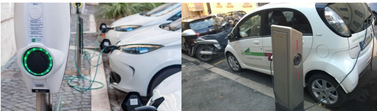
Σχήμα 9.44: Σταθμοί φόρτισης ηλεκτρικών οχημάτων παρά την οδό
