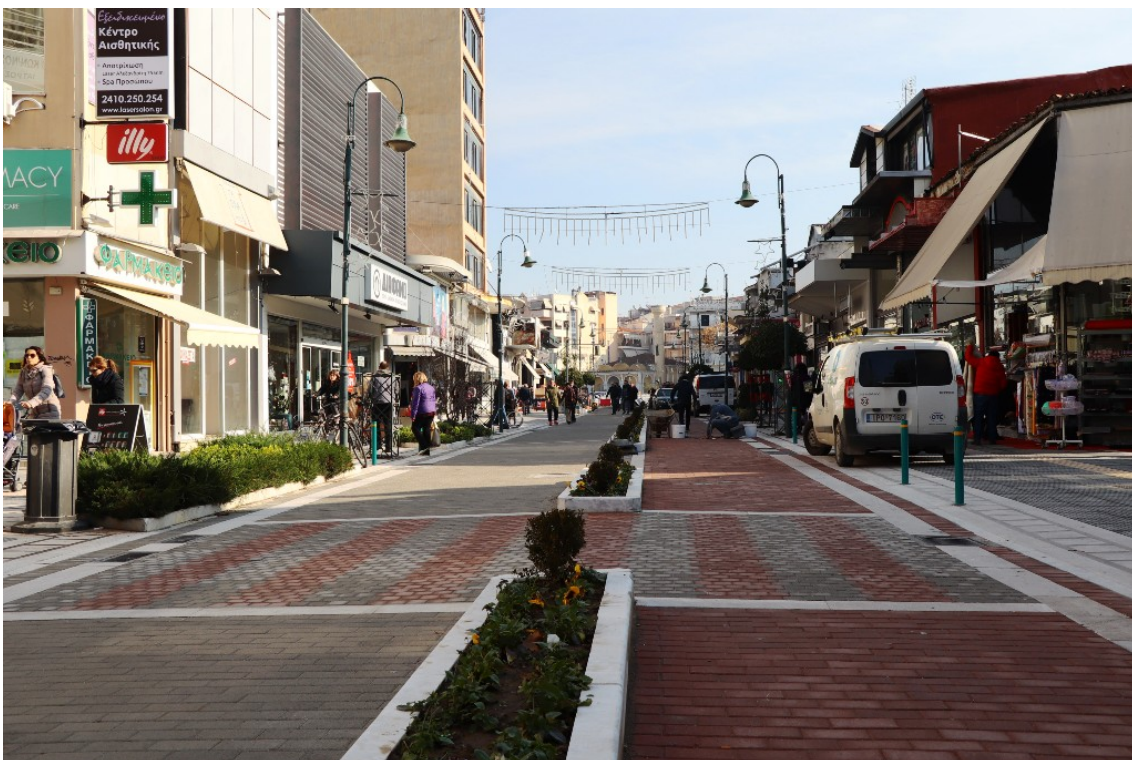
Σχήμα 9.4: Αλλαγή υφής και χρώματος επί του οδοστρώματος
