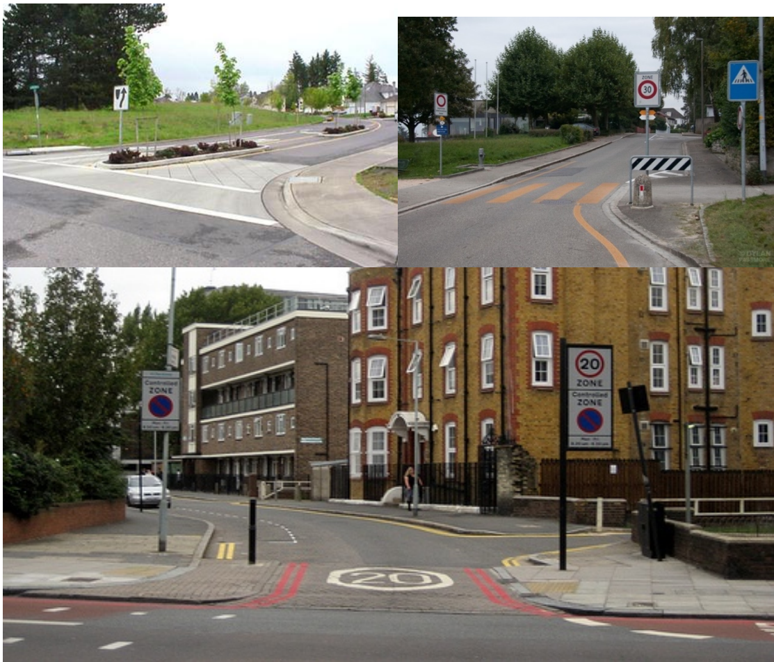
Σχήμα 9.13: Μέτρα ήπιας κυκλοφορίας σε εισόδους στο τοπικό δίκτυο και περιοχές κατοικίας
